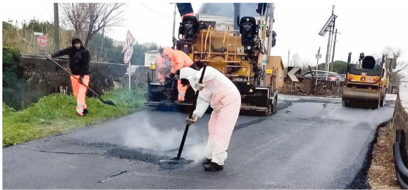
Operai al lavoro per la sistemazione del manto stradale in via di Palazzetto
